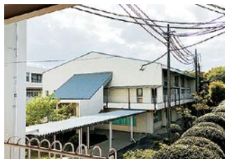
C棟 昭和53年築
